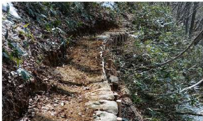
屏風岩下、作業完了
