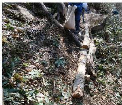
⑮杭打って土台造り
