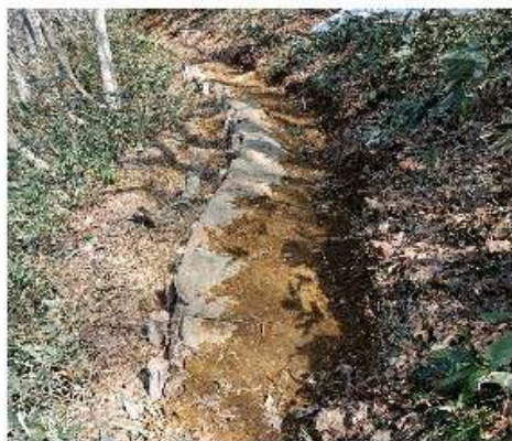
「雪の回廊」の上、作業完了
